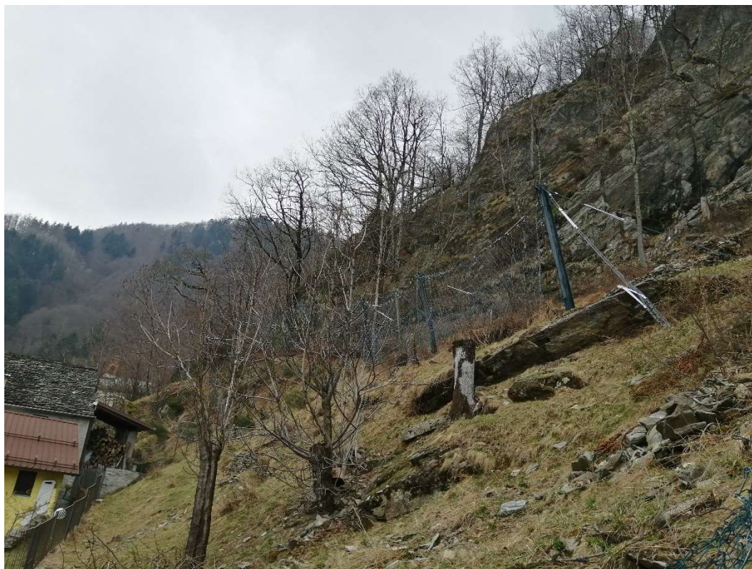
Barriere paramassi a monte delle Frazioni Giavina e Cadiano
