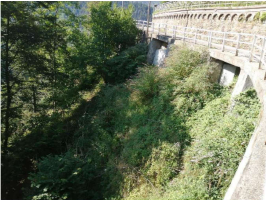
Scoronamento e ciglio in erosione di monte, sotto la s.c. delle frazioni
