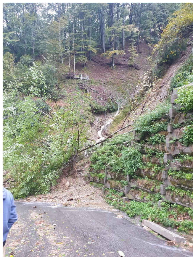
Immagini dell'Alluvione Ottobre 2020 Scoronamento del ciglio di scarpata con danneggiamenti localizzato della rete armata
